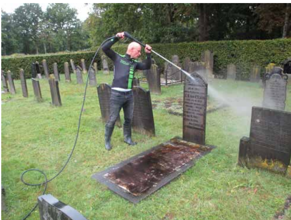
Wim van Triest reinigt een grafmonument met de hogedrukspuit.
